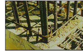
Συνεχόμενος συνδετήρας στην κατασκευή
